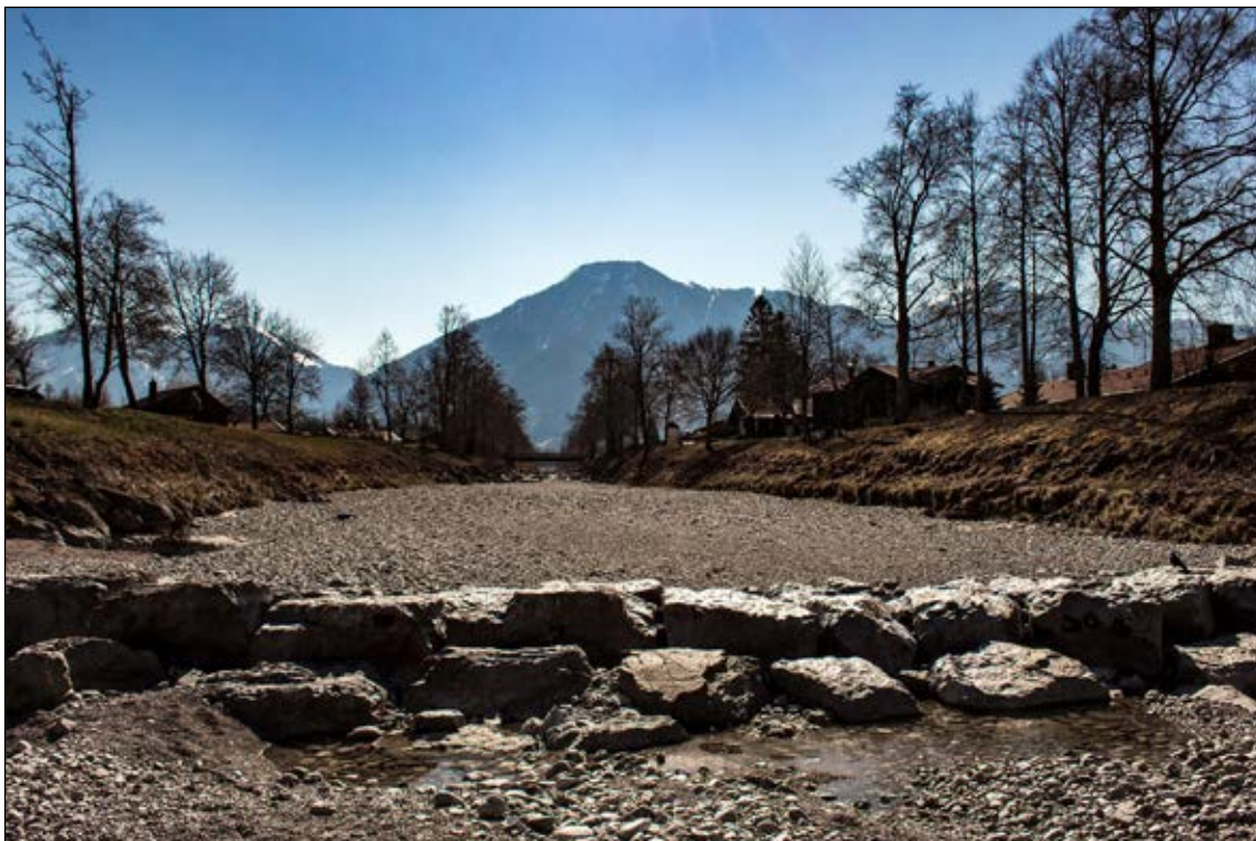
Die Bachläufe waren zeitweise komplett ausgetrocknet.
