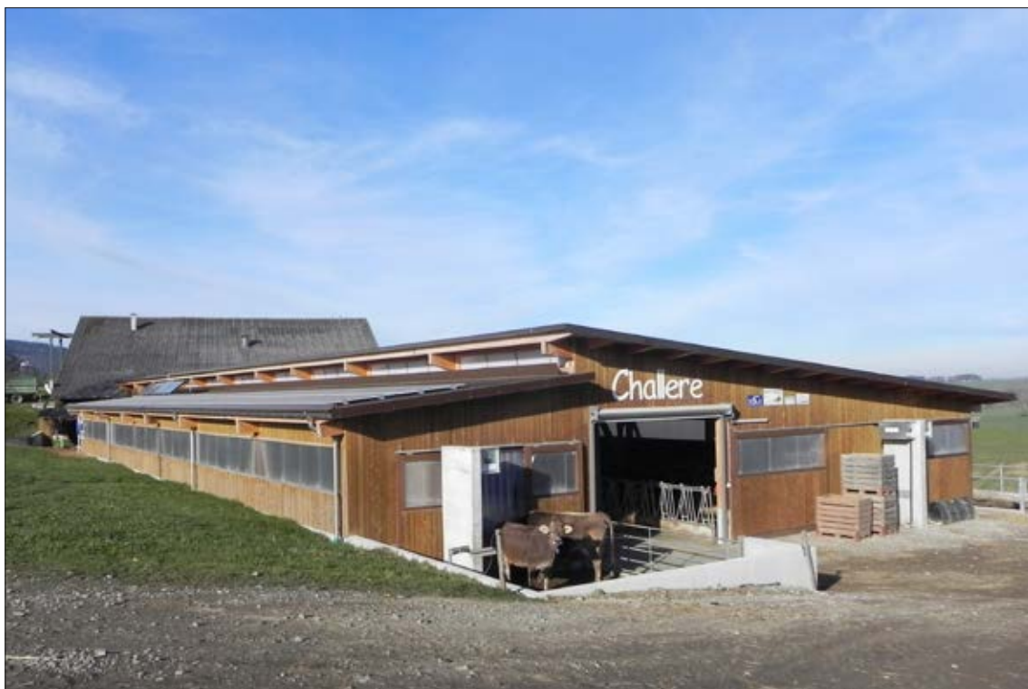
Gelungener Stallanbau an die bestehende Scheune, die weiterhin als Futterlager genutzt wird.
