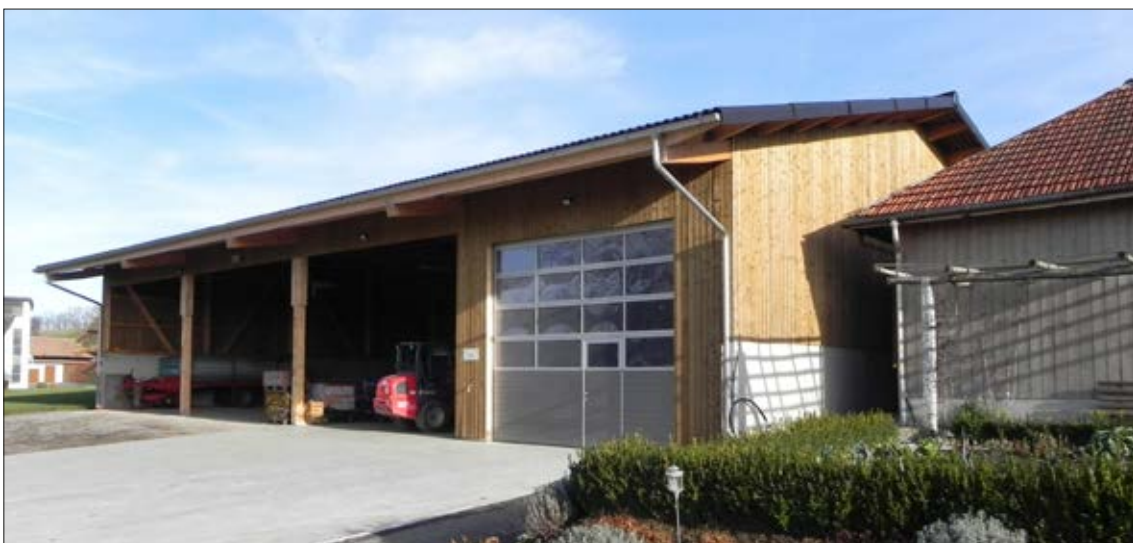
Maschinenhalle mit Werkstatt, die sich gut in die Umgebung einfügt.
